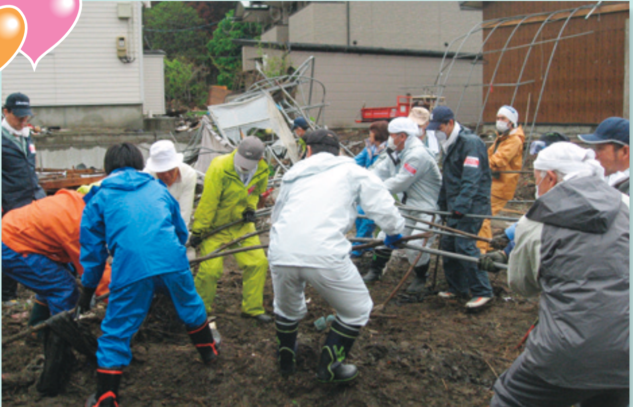
5月28日(土) がれきの撤去作業
